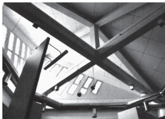
2階ダクト・梁写真
