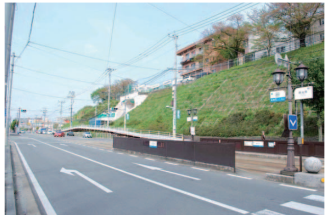
図7 段山電停付近/段山は消滅(平成27年4月)
