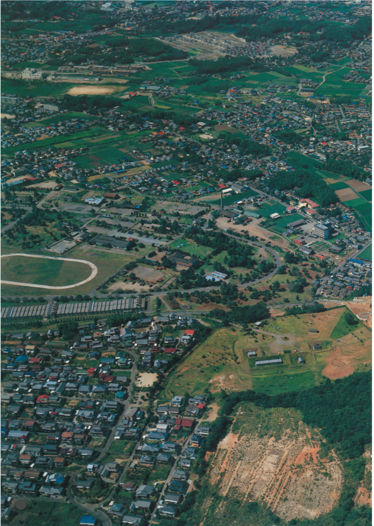
写真2 造成工事中の岩倉山 空撮（註1より転載：一部加筆）
