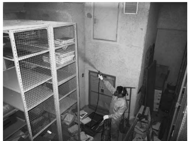
ガス燻蒸（投薬状況）
