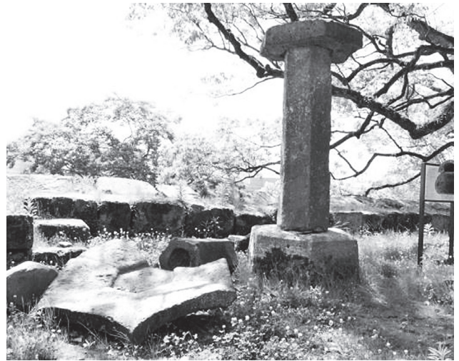
【図2】本幢の被害状況
