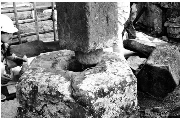
【図4】 幢身下部の柄と基礎の柄穴（解体時）
