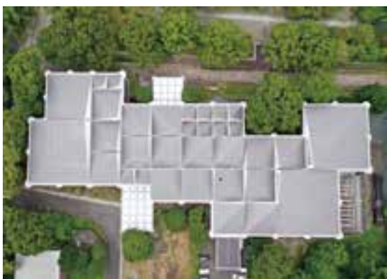
写真1 熊本博物館外観(上空から)
